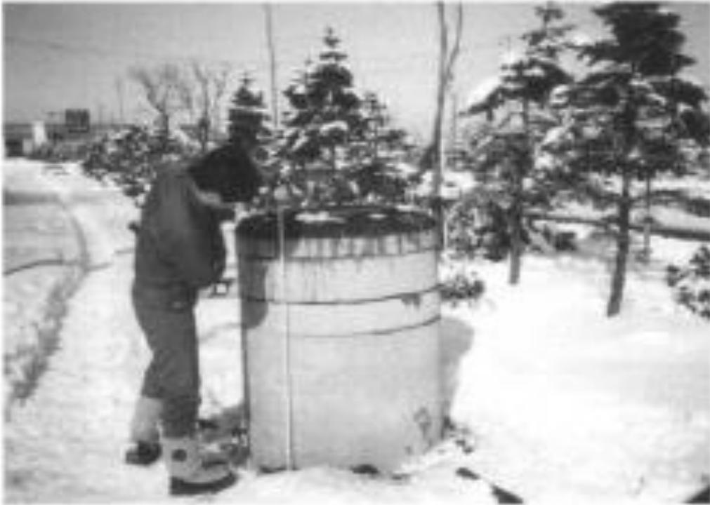
写真-1 液状化により浮上したマンホール
